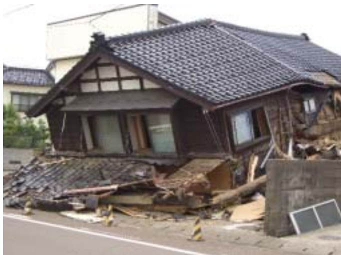
倒壊した家屋（柏崎市西本町）
